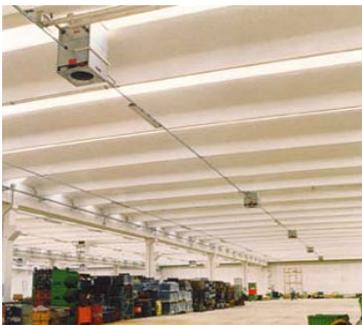
Монтажная высота - важный критерий, влияющий на возможность применения вентиляционных агрегатов на объектах с очень высокими потоками, например в аэродромных ангарах. Пионер, начавший производить оборудование такого типа, - фирма HOVAL (Лихтенштейн). Благодаря запатентованной системе диффузора AIR INJECTOR и мощным вентиляторам дальность струи воздуха, подаваемого агрегатами HOVAL, достигает 25 м.
